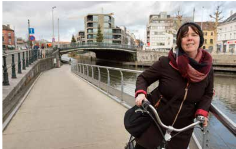
Fietsers en voetgangers kunnen onder de brug door en hoeven de drukke straat die het stadscentrum met het station Gent Dampoort verbindt niet te kruisen.
